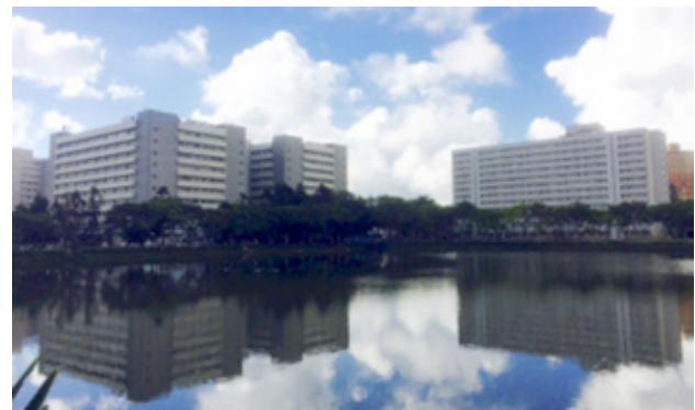
Figura 1: Imagen exterior el complejo del Chang Gung Memorial Hospital de Linkou.
